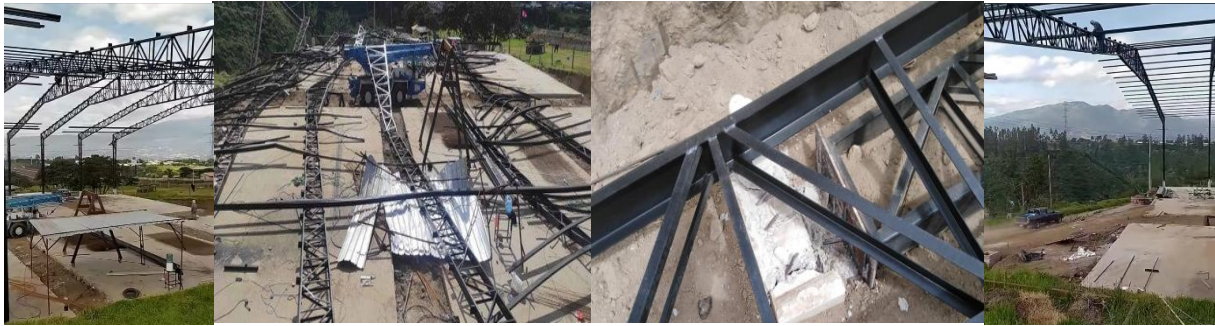
Figura 2 Colapso de Cubiertas en el Ecuador durante la fase de construcción.
