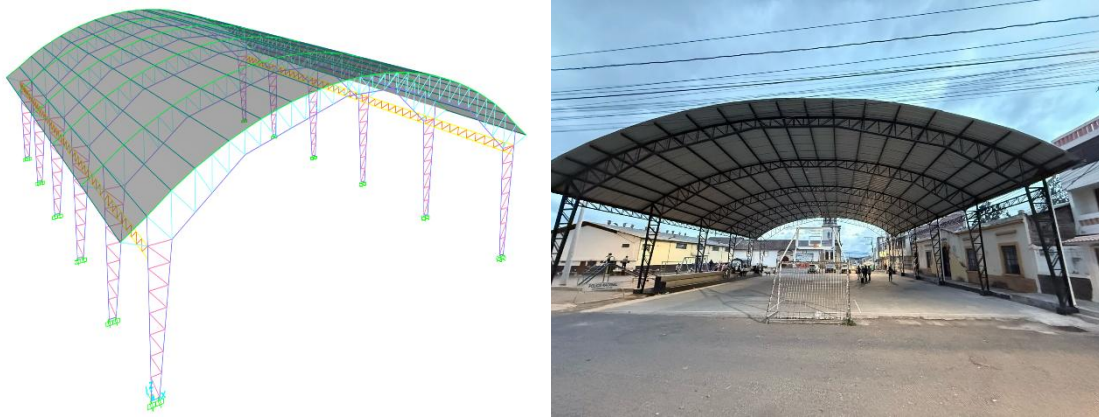
Figura 3 Modelo Estructural y Modelo Físico de la Nave Industrial
